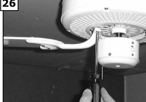
Installer des pales à l'utilisation de moteur 10 vis de moteur fournies. Resserrer des vis assurément.
