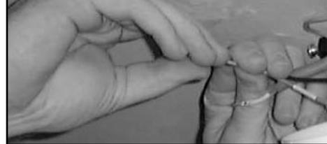
Reliez tous les fils électriques à la source d'énergie en utilisant les capuchons électriques fournis à cet effet. Assurez-vous qu'aucun filament ne dépasse des capuchons électriques. Après avoir établi les liaisons électriques, vous devez étaler les fils en mettant le conducteur mis à la masse et le conducteur de mise à la terre de l'appareillage d'un côté du boîtier de sortie de courant et le conducteur non mis à la terre de l'autre côté de la boîte de sortie de courant.
