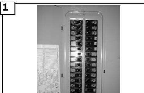
**1** Avant de procéder à l'installation du ventilateur, coupez le courant au niveau du panneau d'entrée d'électricité et verrouillez le dispositif de sectionnement pour éviter que le courant ne soit branché accidentellement. Si vous ne parvenez pas à verrouiller le dispositif de sectionnement, placez sur le panneau d'entrée d'électricité une pancarte ou une étiquette de mise en garde bien visible.
