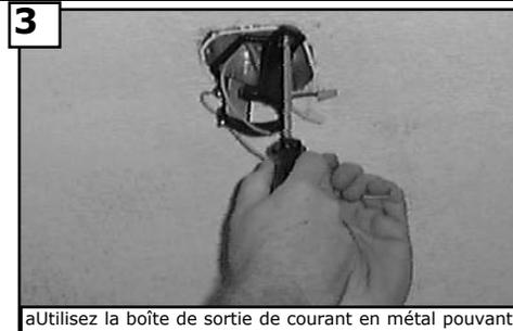
**3** Utilisez la boîte de sortie de courant en métal pouvant supporter le poids du ventilateur (15,8 kg). Avant de relier le ventilateur à la boîte de sortie de courant, assurez-vous que celle-ci est parfaitement attachée au moins en deux points à une pièce de charpente du plafond (une boîte de sortie de courant mal attachée provoquera des secousses du ventilateur). Utilisez uniquement les vis fournis avec le boîtier de sortie de courant.
