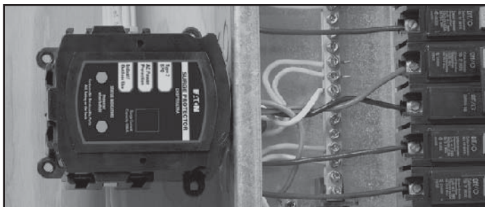
Figure 2. Panel Mount Installation (2)/Installation au panneau (2)/Instalación en el centro de carga
