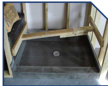
Photo d'installation No 8
