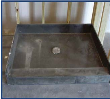
Fotografía de Instalación 3
