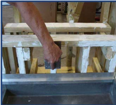
Fotografía de Instalación 5
