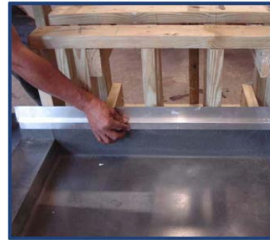
Photo d'installation No 4
