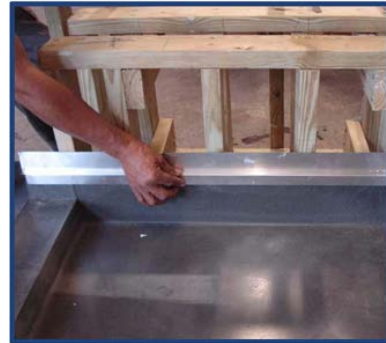
Fotografía de Instalación 4
