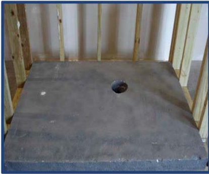
Fotografía de Instalación 1
