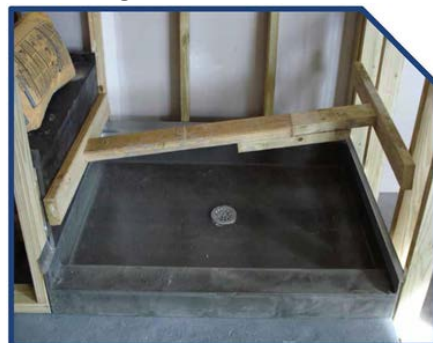
Fotografía de Instalación 8
