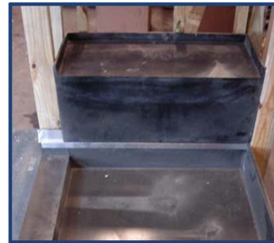
Photo d'installation No 6
