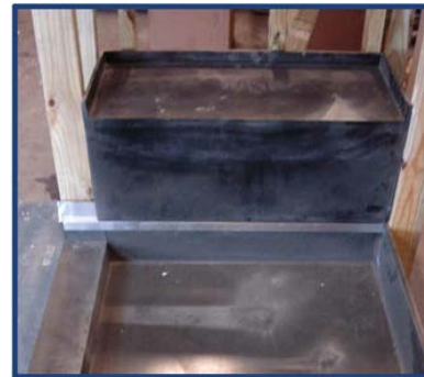
Fotografía de Instalación 6
