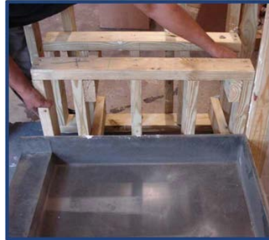
Fotografía de Instalación 2
