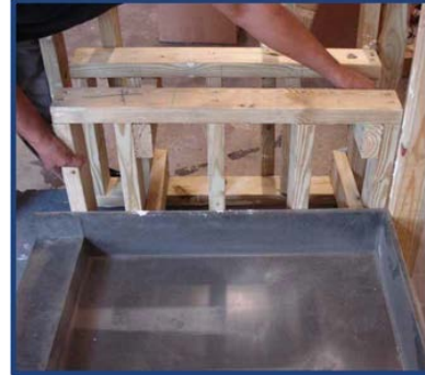
Photo d'installation No 2
