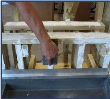
Photo d'installation No 5
