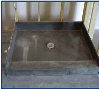
Photo d'installation No 3
