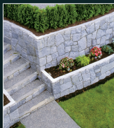
Retaining Walls paredes de contención
