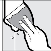
Con una espátula de 6 pulgadas, aplique a lo largo de la junta una capa uniforme de compuesto para juntas.
