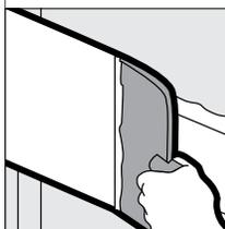
Para las juntas biseladas, aplique el compuesto para juntas en toda la longitud de la junta con una espátula de 8 o de 10 pulgadas. El compuesto para juntas debe extenderse 2 pulgadas más allá de la primera capa hasta un ancho total de 7 a 10 pulgadas.
