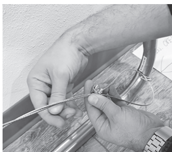
ORIFICIO EN LA ESQUINA INFERIOR DEL LADO DEL PESTILLO
