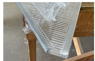
Attach U-Channel: Angled Edge
