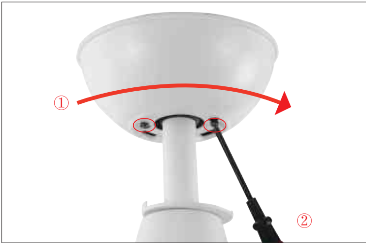
Paso 14 ①Empuje la base hacia arriba y gírela. ②Aprieta los dos tornillos.
