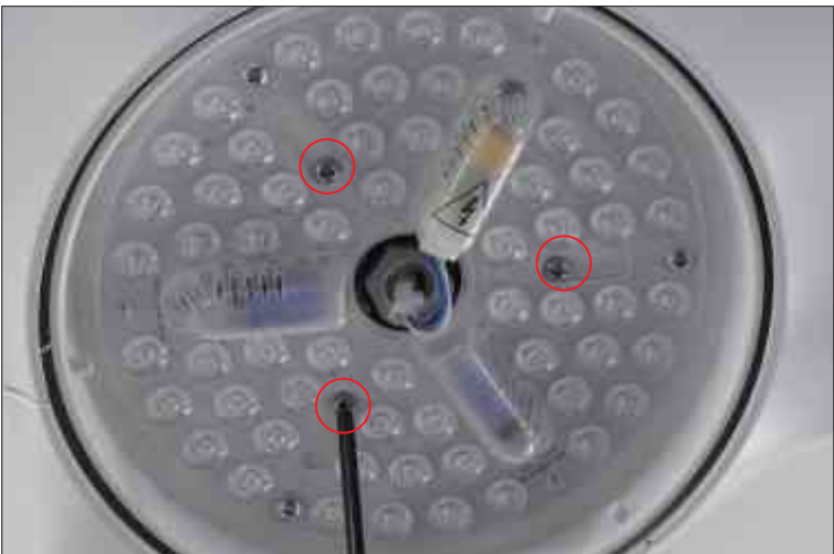
Paso 19 Instale la placa de la luz.
