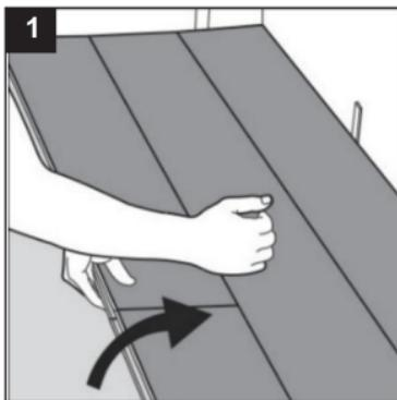
2. Desensamble los paneles levantándolos por debajo del extremo corto.
