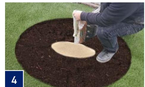
Vierta 1 ½ "a 2" de la base de la pavimentadora / arena gruesa dentro del área excavada, asegurando que la altura de la arena sea uniforme y nivelada. Rocíe la arena con agua y usa un pisón manual para compactar uniformemente toda el área dentro del círculo. Vierta ½ "adicional de la base / arena de la pavimentadora en el área circular y nivelada. No compactar.
