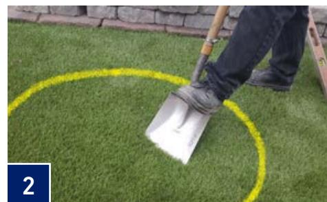
Cuando instale el Kit Firepit en un área de césped o césped, marque un círculo de 49 "(125 cm) de diámetro con pintura para marcar y continúe con el Paso 2. Si lo instala en un área de patio adecuada, use tiza en lugar de pintura para dibujar un 49" (125 cm) círculo de diámetro y continúe con el Paso 5.
