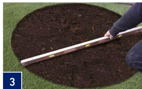
Cree un área nivelada y uniforme con su pala para eliminar los puntos altos. Asegúrese de que el área de la superficie dentro del círculo esté nivelada utilizando un nivel de hogar estándar.
