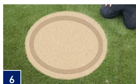
Coloque cuidadosamente el anillo de fuego de acero, con el lado de la brida hacia abajo en la base / arena de la pavimentadora, creando una muesca. Con cuidado, levante el anillo de fuego hacia arriba, tratando de perturbar la menor base de pavimentadora / arena posible. Este paso creará una marca circular o una guía para que comiences a colocar el bloque para tu Kit Firepit.
