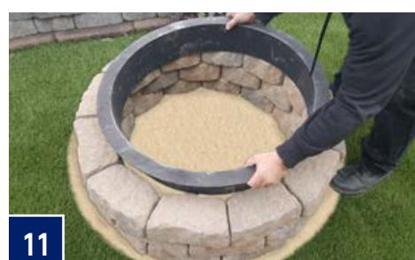
El borde exterior del anillo de fuego de acero descansará en el borde interior del bloque de pared. Asegúrese de que el anillo esté completamente incrustado y que el borde del anillo esté en contacto con la superficie superior del bloque alrededor del tercer curso. Vuelva a alinear el bloque si es necesario golpeándolo contra el inserto de acero y igualar cualquier espacio grande entre los extremos del bloque.
