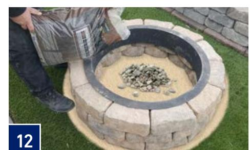
Después de que el adhesivo de concreto se haya secado, llene el fondo del pozo de fuego con grava / roca de lava, nivelando el material a medida que lo llena. La grava / roca de lava debe llenarse hasta el borde inferior del anillo de fuego de acero.
