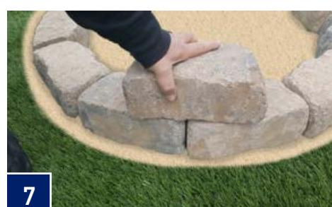
Este paso se denomina "ajuste en seco" para garantizar la colocación del bloque antes de adherirse en su lugar en el paso 8. Al colocar el segundo curso de bloques, asegúrese de seguir un patrón de "uno sobre dos", alineando el centro de cada bloque sobre la junta hecha entre dos bloques debajo de él. Asegúrese de que los bloques estén nivelados de adelante hacia atrás y de lado a lado a medida que completa el anillo del segundo curso.
