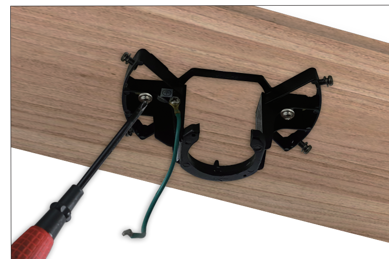
Paso 1 Para techos de madera, instale la en el techo de madera con dos tornillos para madera.
