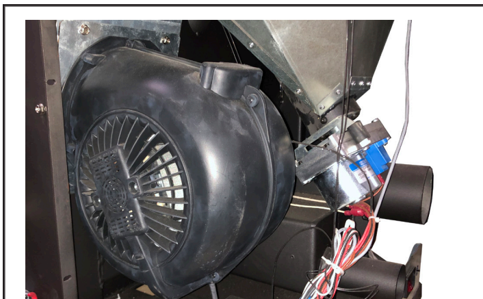
Figura 25: Soplador de intercambio de calor de H3W80XL
