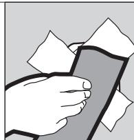
Recorte todo material suelto y límpie el área afectada. Aplique bastante cantidad de compuesto para juntas alrededor de los bordes y recubra el perímetro del agujero.
