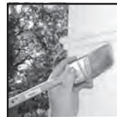
8. Pinte con una pintura de látex acrílico o a base de aceite de alta calidad. Retire por completo todo el polvo y la suciedad, para esto limpie la columna con un limpiador compatible con la pintura que escogió (aguarrás mineral para pinturas a base de aceite, Simple Green® o alcohol isopropílico para pinturas de látex acrílico). Deje que seque completamente antes de pintar.
