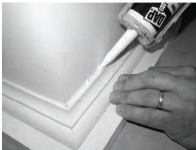
20) Calafatee usando el látex que calafatea el compuesto para llenar cualquier boquete y para clavar o para atornillar los agujeros.
