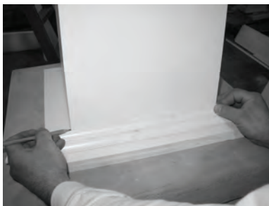
17) Utilice el eje de la columna para comprobar longitud del moldeado bajo del ajuste. Si el ajuste es demasiado largo, marque las líneas de corte para los ingletes.
