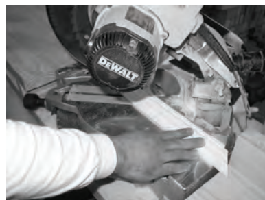
18) Si los moldeados bajos del ajuste son demasiado largos, el inglete del uso vio para cortar pedazos bajos del ajuste para caber alrededor de la parte inferior de la columna.
