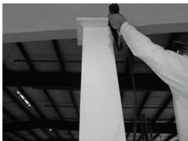
16) Aplique el pegamento al pedazo y a las galletas finales del casquillo del \frac{1}{4} y resbale dentro de lugar. moldeados del casquillo del Pin-clavo a la tapa de column.*
