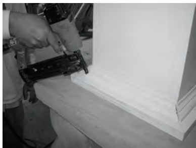
19) Aplique el pegamento a los moldeados bajos del ajuste y el perno-clavo en lugar.
