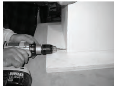
15) Tornillo o el panel final del clavo a asegurar en el lugar.
