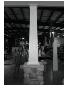
21) Limpie la superficie de la columna con el limpiador recomendado por el fabricante de la pintura. Pinte con 2 capas de pintura de látex de acrílico.
