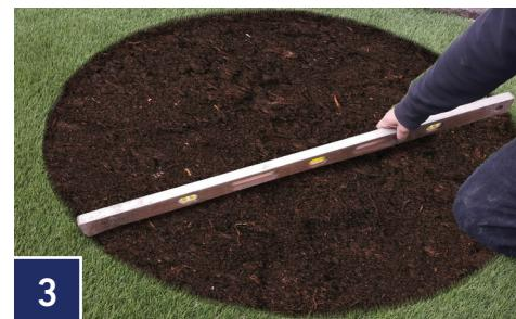
Cree un área nivelada y uniforme con su pala para eliminar los puntos altos. Asegúrese de que el área de la superficie dentro del círculo esté nivelada utilizando un nivel de hogar estándar.
