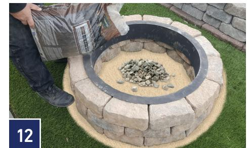
Después de que el adhesivo de concreto se haya secado, llene el fondo del pozo de fuego con grava / roca de lava, nivelando el material a medida que lo llenas. La grava / roca de lava debe llenarse hasta el borde inferior del anillo de fuego de acero.
