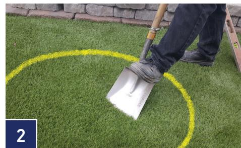
Con una pala, elimine todo el césped, la suciedad, las raíces y cualquier otro material orgánico, cavando a una profundidad uniforme de 2 "dentro del área del círculo.
