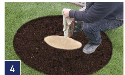
Vierta 1 ½ "a 2" de la base de la pavimentadora / arena gruesa dentro del área excavada, asegurando que la altura de la arena sea uniforme y nivelada. Rocíe la arena con agua y usa un pisón manual para compactar uniformemente toda el área dentro del círculo. Vierta ½ "a 1" adicional de la base / arena de la pavimentadora en el área circular y nivelada. No compactar.
