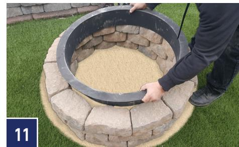
El borde exterior del anillo de fuego de acero descansará en el borde interior del bloque de pared. Asegúrese de que el anillo esté completamente incrustado y que el borde del anillo esté en contacto con la superficie superior del bloque alrededor del tercer curso. Vuelva a alinear el bloque si es necesario golpeándolo contra el inserto de acero y igualar cualquier espacio grande entre los extremos del bloque.
