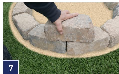
Este paso se denomina "ajuste en seco" para garantizar la colocación del bloque antes de adherirse en su lugar en el paso 8. Al colocar el segundo curso de bloques, asegúrese de seguir un patrón de "uno sobre dos", alineando el centro de cada bloque sobre la junta hecha entre dos bloques debajo de él. Asegúrese de que los bloques estén nivelados de adelante hacia atrás y de lado a lado a medida que completa el anillo del segundo curso.
