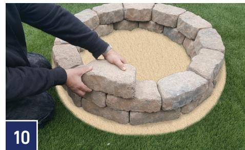
Ajuste en seco el tercer curso de los bloques con las juntas en los extremos alineadas con las juntas en el primer curso. Aplique el adhesivo como se indicó anteriormente en el Paso 8. Después de que todos los bloques estén en su lugar y mientras el adhesivo aún esté fresco, deslice el anillo de fuego de acero hacia el centro del proyecto. El bloque puede moverse ligeramente o debe deslizarse hacia afuera para permitir que el anillo de fuego caiga en su lugar.
