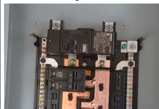
FIG. 2 Install Interlock
